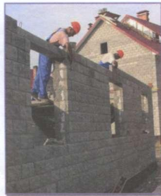
Рис. 26. Выкладка кирпичной стены
