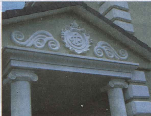
Рис. 29. Оформление здания лепными изделиями
