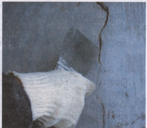
Рис. 46. Разрезание трещины
