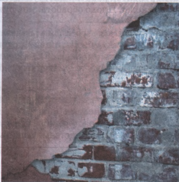
Рис. 43. Отслоение штукатурки
