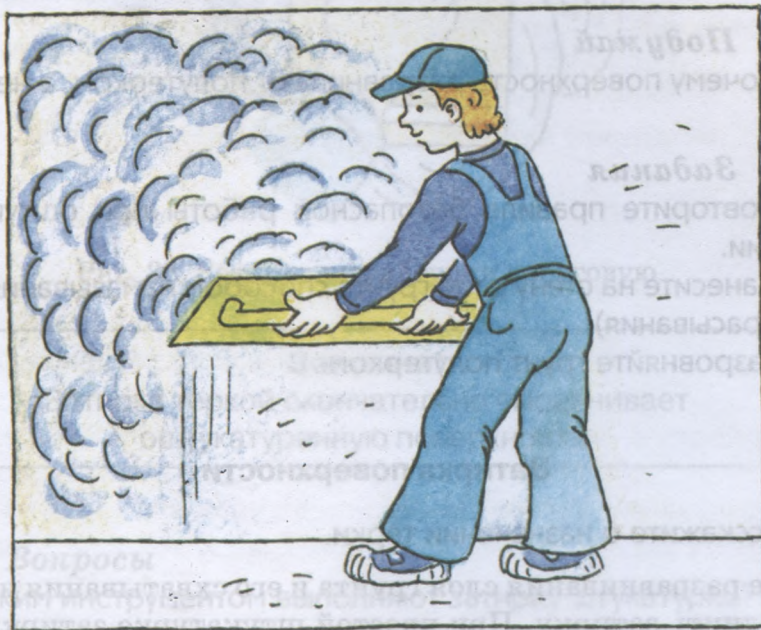
Рис. 27. Разравнивание раствора полутерком
