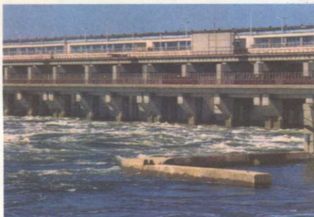
Рис. 55. ГЭС на Волге
