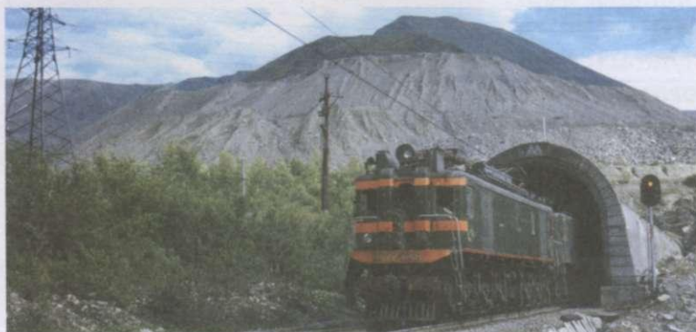
Рис. 27. Тоннель в Хибинах
