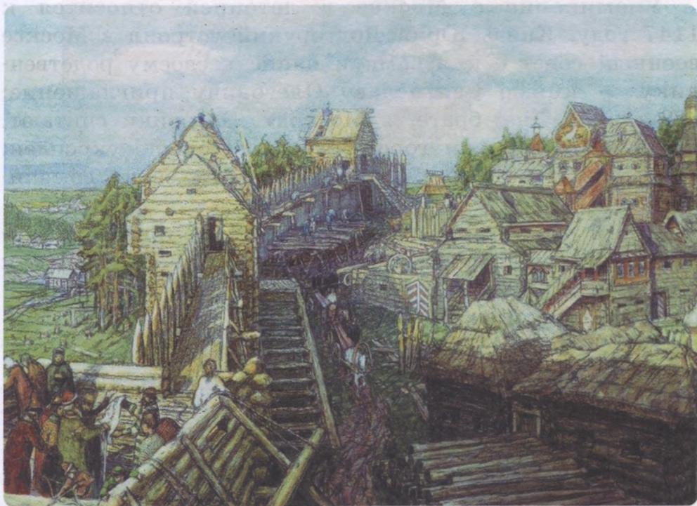
Строительство деревянных стен Кремля. XII век. Художник А. М. Васнецов.
